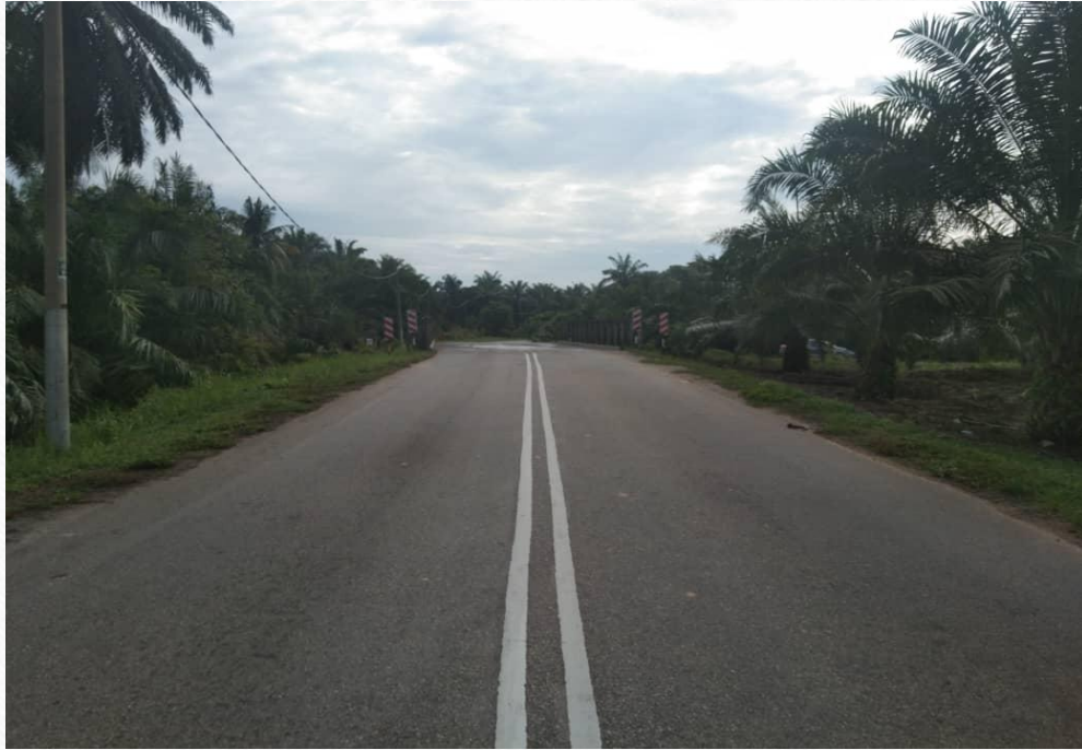
Keadaan jalan 50meter dari arah Simpang Empat Semanggol ke Jambatan Sg. Air Hitam. Lebar jalan sediada 7.7meter
