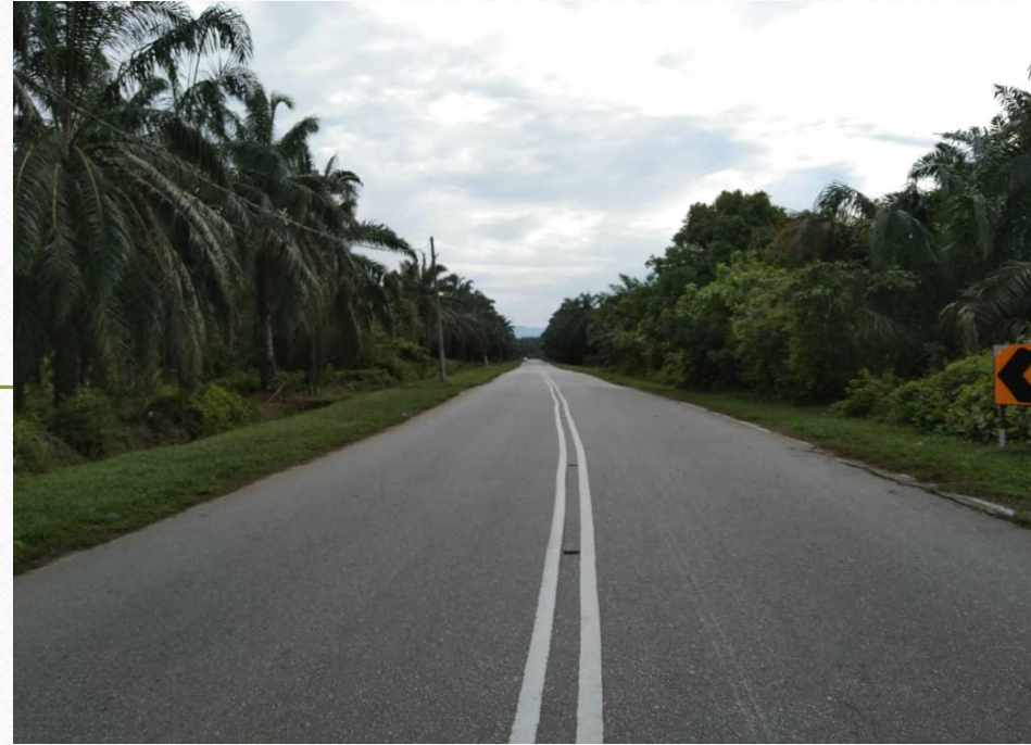
Keadaan jalan 500meter dari arah Simpang Empat Semanggol ke Jambatan Sg. Air Hitam. Lebar jalan sediada 8.0meter
